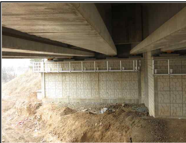
교대 A1(오창방향) 전경
